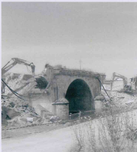
INCORONATA Ponte sul Cervaro
